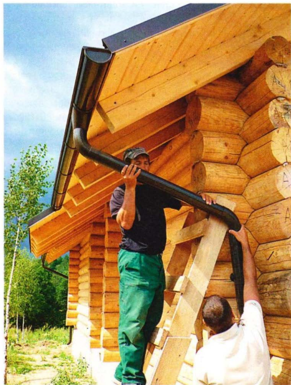
Монтаж водосточных труб.
