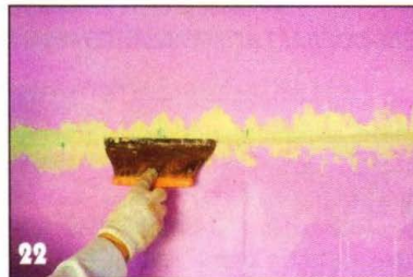
22 Предварительно прогрунтовав поверхности, шпатлюем все неровности и щели.
