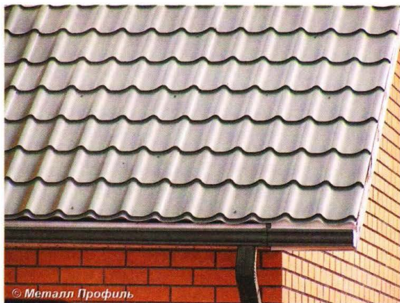
Водостоки прямоугольного сечения американского типа.
