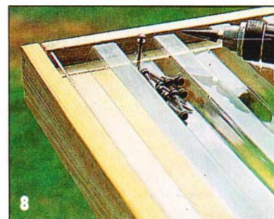
Крепёжные отверстия в листовом пластике лучше всего сверлить коническим или ступенчатым сверлом.
