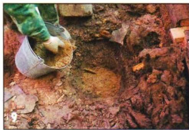
На дно каждой ямки засыпали песок слоем толщиной порядка 10 см и хорошо его утрамбовали.
