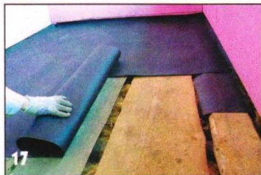
17 Поверх чёрного пола настелили пергамин, укладывая полосы с взаимным перекрытием в 15 см.
