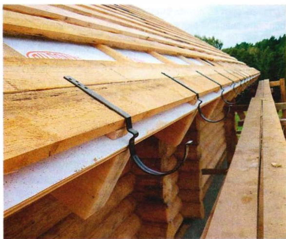
Держатели желобов установлены.
