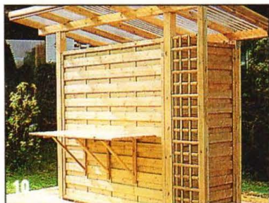
Решётчатая шпалера укрывает площадку рядом с обшитой досками боковой стеной хозблока.
