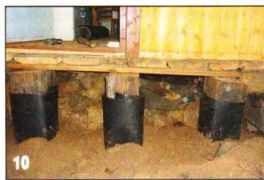
Под поперечину, соединяющую концы половых досок прихожей, установили три столбчатые опоры.
