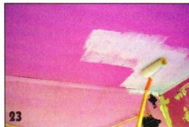
23 Работая валиком, покрываем потолок белой вододисперсионной краской.
