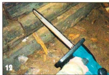
С помощью цепной электропилы сделали прорезы в брёвнах сруба в местах установки половых лаг.
