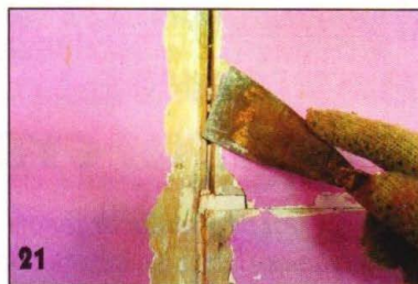
21 Удаляем старую отслоившуюся шпатлёвку.
