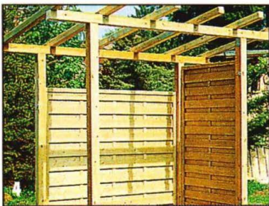
Одну из боковых стен строения тоже зашивают досками, так что стойка имеет ограждение с трёх сторон.
