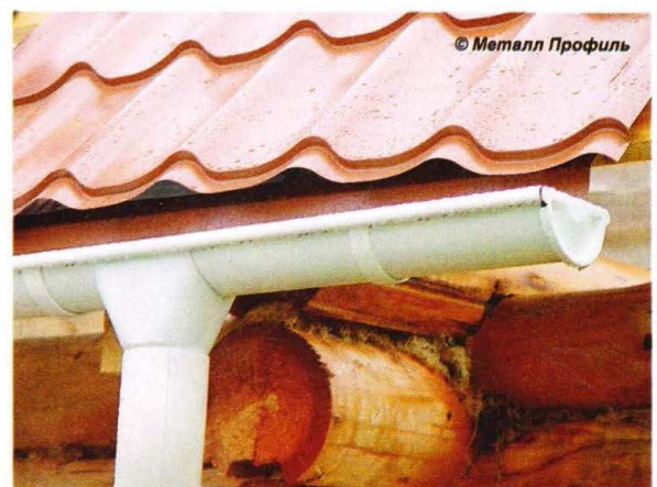
Водостоки круглого сечения скандинавского типа.
