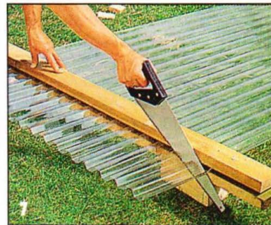
Гофрированные или другие кровельные листы из пластика легко поддаются резанию обычной мелкозубой ножовкой по дереву. При раскрое лист нужно закрепить между двух досок.
