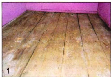
Под оргалитовым покрытием обнаружили черный пол, состоящий из толстых хорошо сохранившихся досок.
