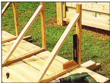
Опоры рабочего стола делают в виде угловых кронштейнов с подкосами и прикрепляют к стене.
