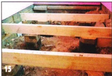
15 Перестраховавшись, под каждую лагу установили по две опоры.
