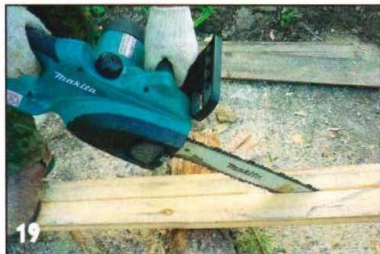
19 Крайнюю доску чистового пола выкроили по месту.
