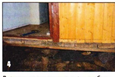
Висящие концы поперечных досок подбили снизу поперечной доской, чтобы под неё подвести опоры.
