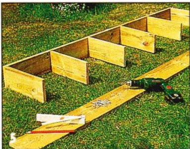
Полку собирают из двух длинных и шести коротких досок, соединяемых впритык на шурупах, и монтируют поверх более низкой стены.
