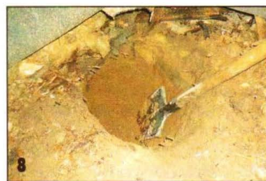
Под опоры выкопали ямки небольшой глубины из расчёта высоты столбиков и толщины песчаной подушки.
