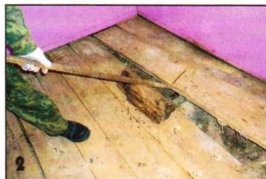
Тяжёлые поперечные доски удалось оторвать только ломом.
