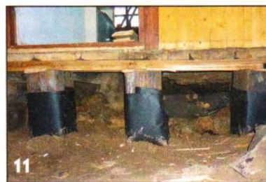
Подсунули между верхними скошенными торцами опор и полом ещё одну доску и, подбивая её клиньями, вывели поверхность пола на требуемый уровень.
