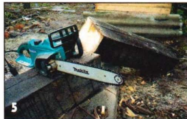
От прежних хозяев участка нам досталось несколько шпал. Предварительно определив высоту опор, нарезали их из шпал.
