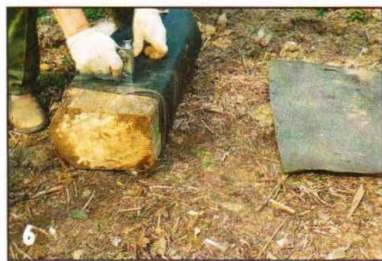
Чтобы избежать непосредственного контакта с землёй и предохранить опоры от гниения, изолировали их пергамином, который прибивали скобками.
